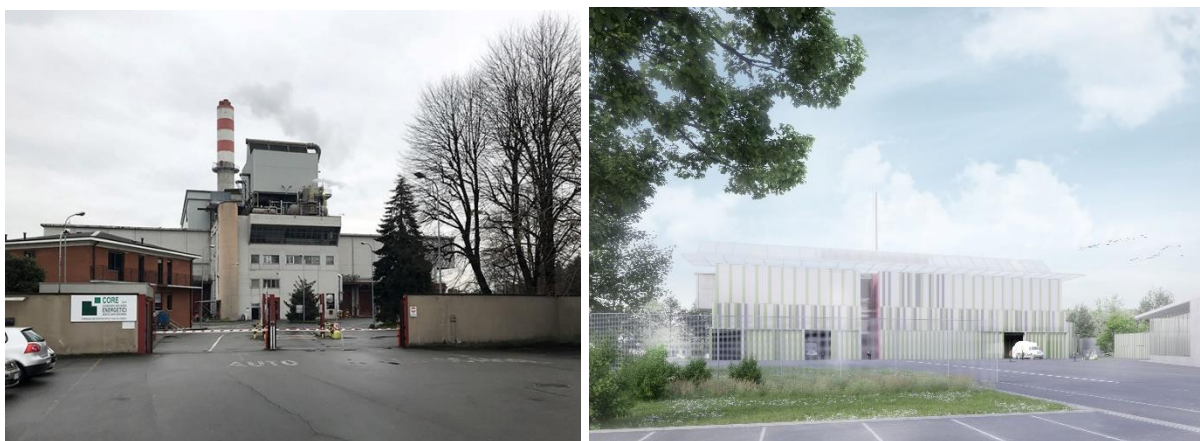
Figura 20 Fotografia dall'ingresso sul piazzale di scarico e sulla sala di controllo, dove verrà realizzata l'avanfossa
